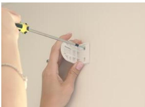
3. Через монтажные отверстия прикрутите кронштейны в отмеченных местах саморезами к стене.
