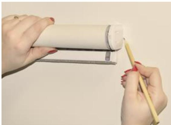
1. Приложите карниз изделия строго горизонтально к стене и в местах крепления кронштейнов сделайте отметки с обеих сторон карниза.
